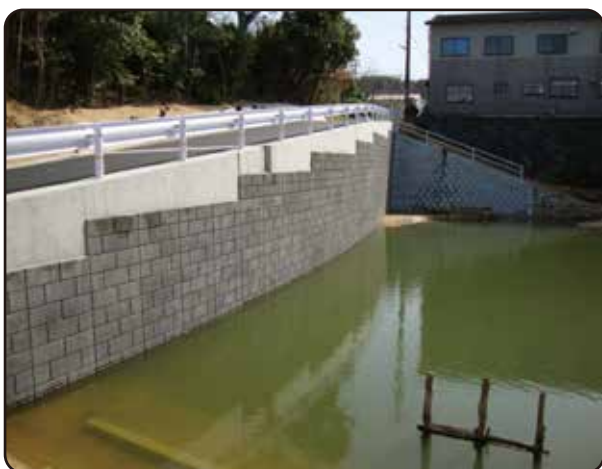
道路拡幅 護岸工【香川県東かがわ市】
