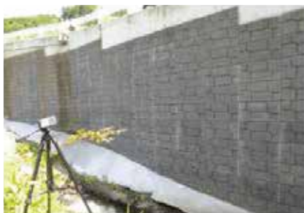
震度6強 最大高さH=7.2m 異常なし
